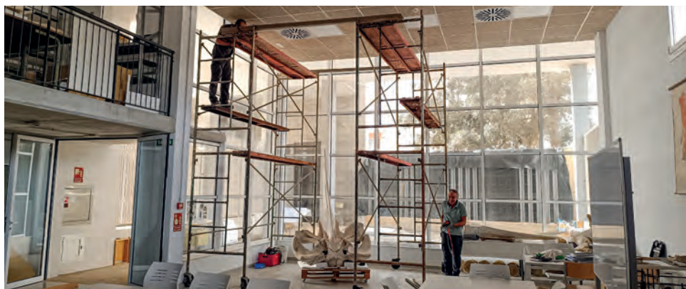
Imatge 10. Primeres passes de preparació per a la instal·lació a la traginada.
